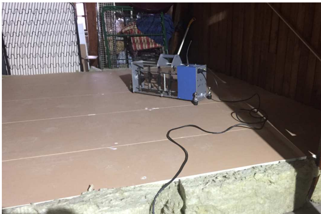
Figur 2. Foto på golvregelsystem 7000N från Granab med 22 mm spånskiva och 13 mm gipsskiva.
